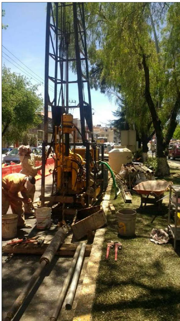
Otra vista de la ejecución del sondeo de penetración estándar SPE-4
