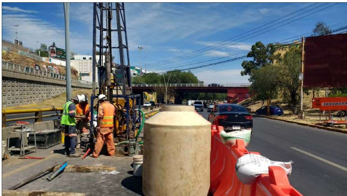
Otra vista de la ejecución del sondeo de penetración estándar SPE-7
