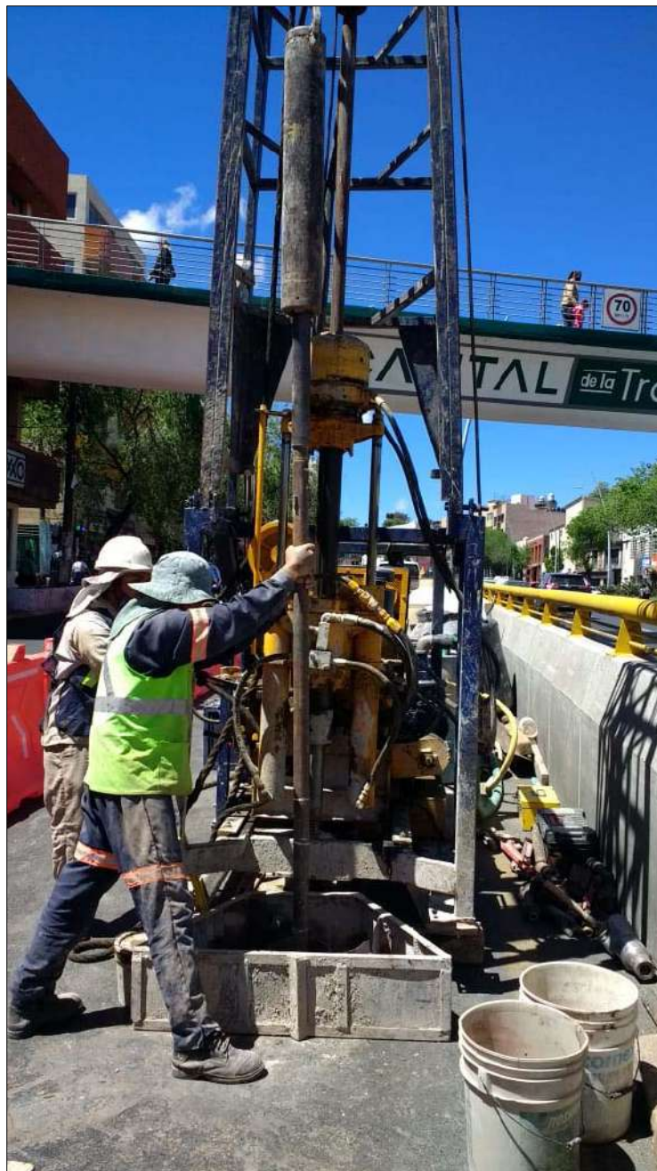
Ejecución del sondeo de penetración estándar SPE-5
