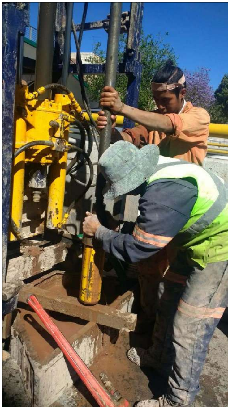
Ejecución del sondeo de penetración estándar SPE-4
