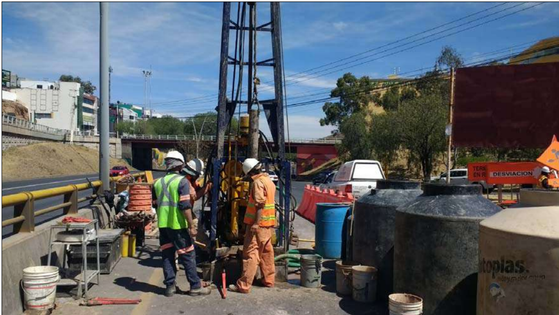
Ejecución del sondeo de penetración estándar SPE-7
