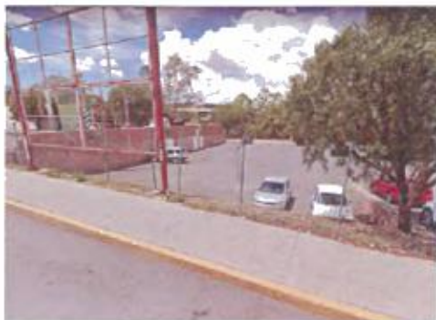
CERCO MALLA CICLONICA DESMANTELAMIENTO SIN RECUPERACIÓN DE MALLA CICLONICA, INCLUYE POSTES. SUP. A DESMANTELAR =728.87 ML
