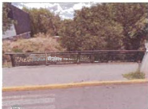
BARANDAL DE ACERO DESMANTELAMIENTO SIN RECUPERACIÓN DE BARANDAL DE ACERO. SUP. A DESMANTELAR =9.26 ML
