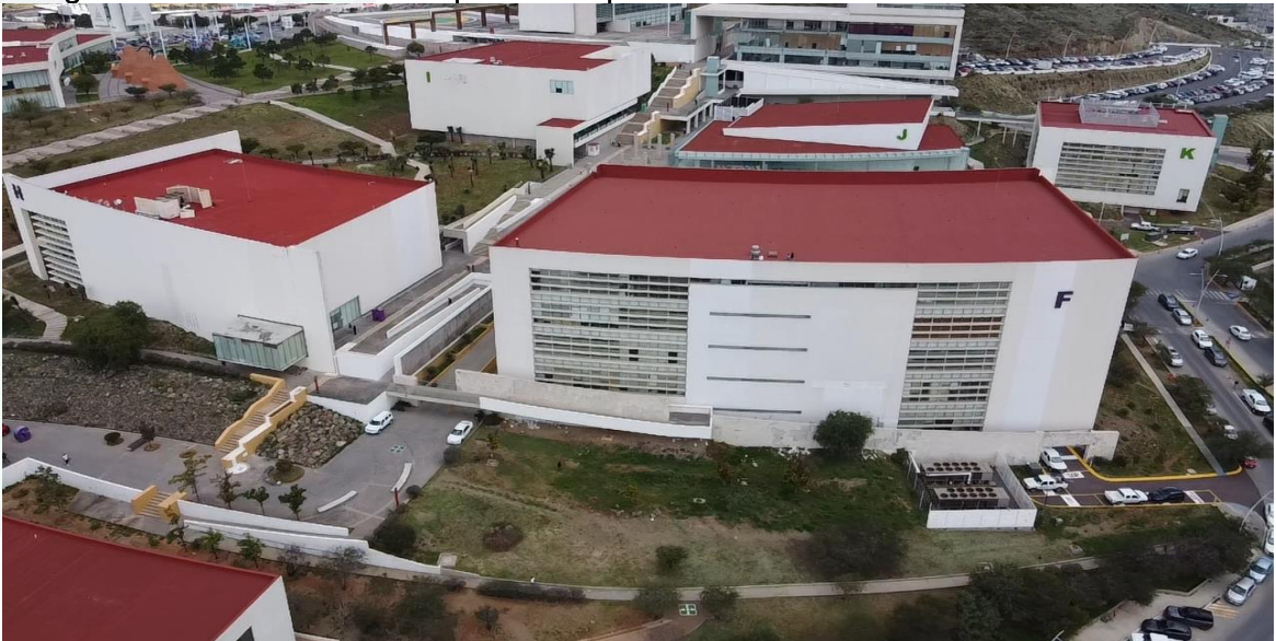
e) Fotografía de la fachada de la dependencia para el SFV.
